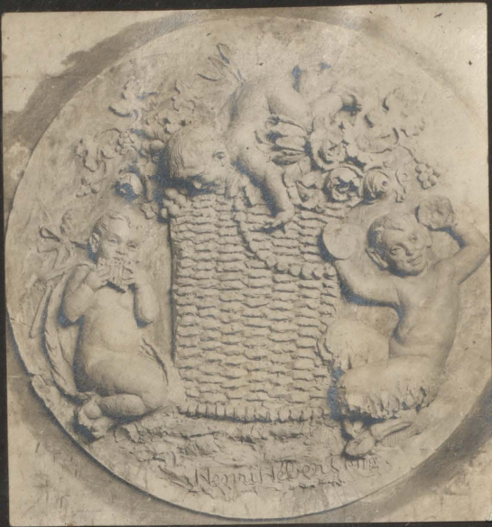
New Banks Bldg OP. 54
