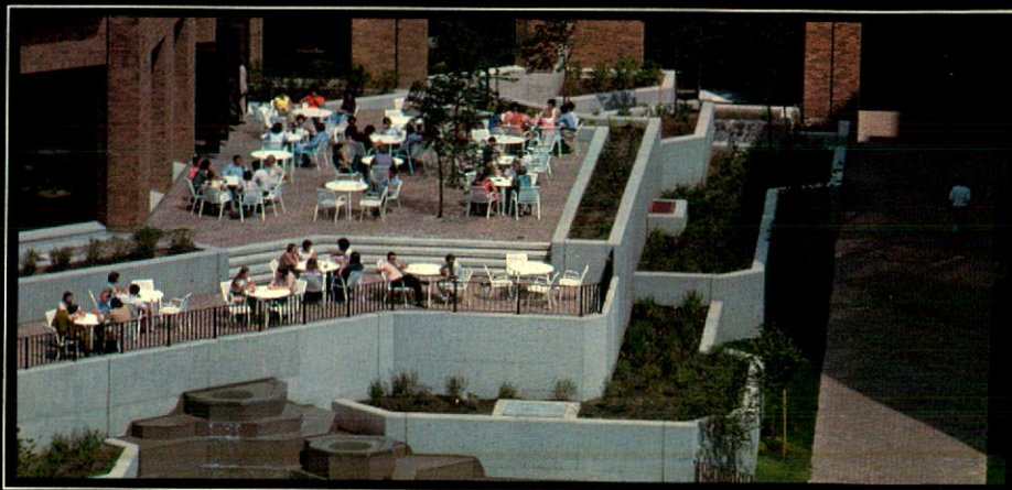
Les Terrasses de la Chaudière, Hull, Québec
