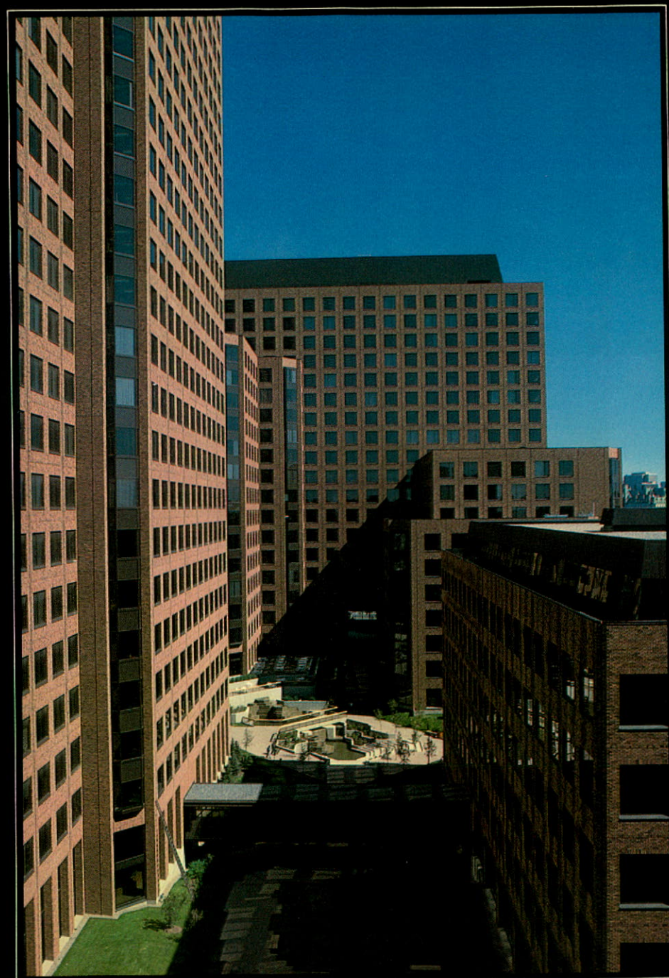
Les Terrasses de la Chaudière, Hull, Québec
