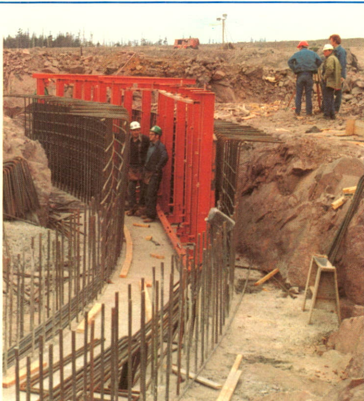
L'aménagement du radier devant servir de base au bâtiment du réacteur au chantier de la centrale de Pointe Lepreau (juin 1975).
