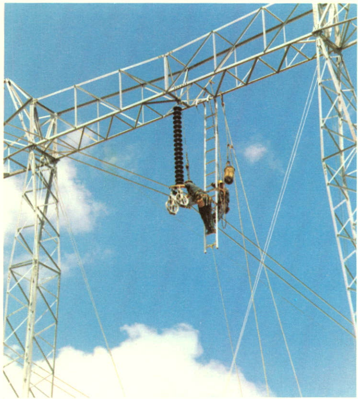
Des monteurs de ligne installent les câbles pour des lignes de 345 KV.
