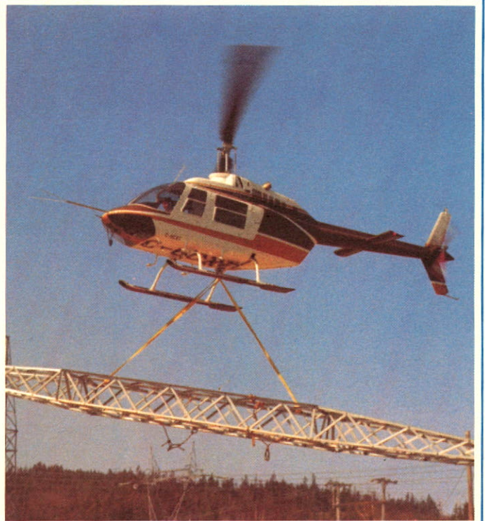
Des hélicoptères transportent les pylônes sur l'emplacement du chantier des lignes 345 KV entre les bornes de Keswick et de Coleson Cove. Ce transport par hélicoptères permet l'aménagement beaucoup plus rapide des pylônes.
