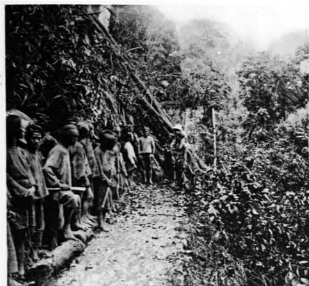
252. Piste obstruée par la chute d'un arbre.
