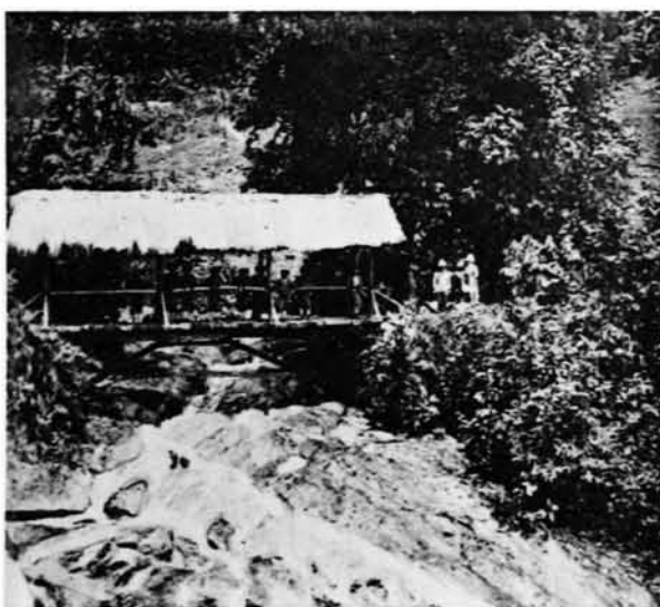
197. Pont couvert; construit par des "Nung".
