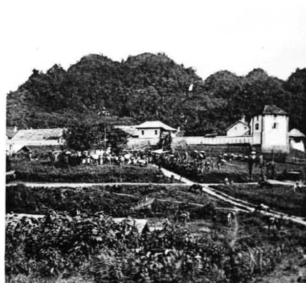
436. Poste de MUONG-KHUONG (pays " Nung ")
