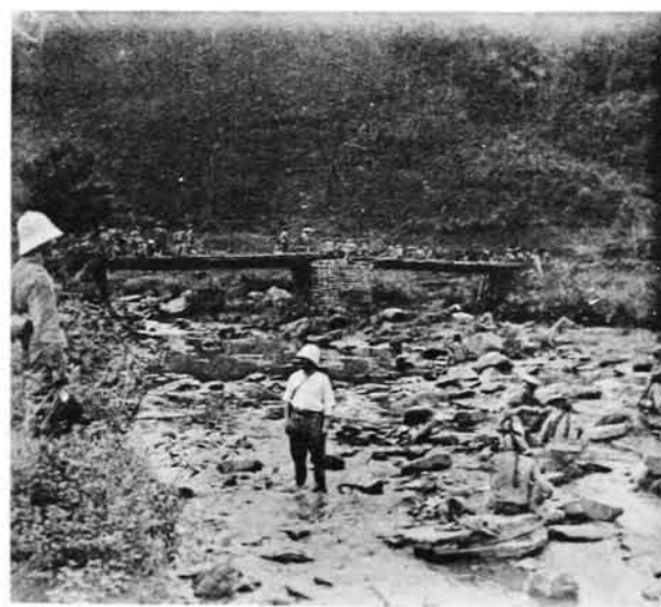
404. Pont à piles en cailloutis (Région de PHONG-THO).
