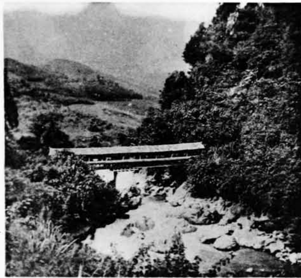
121. Pont en maçonnerie (couvert) sur le MI-HOU.
