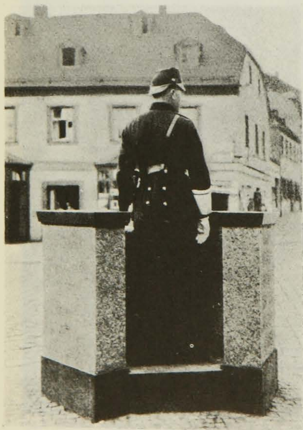
Photo Erwin Goldarbeiter Verkehrsschutz in Hof (Bayern)
