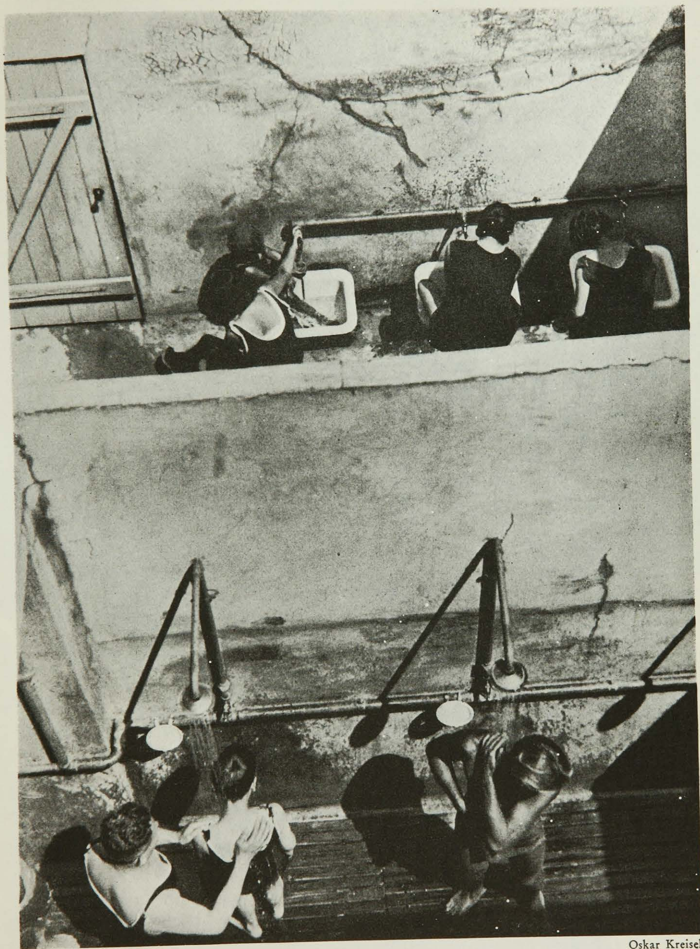
Blick in die Dusche-Räume
