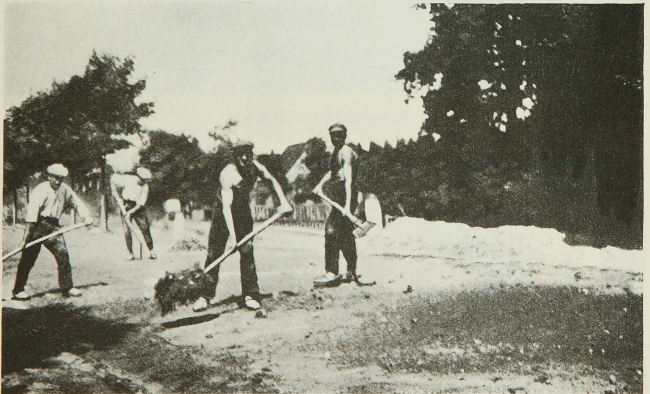
Straßenbau bei Goldap
