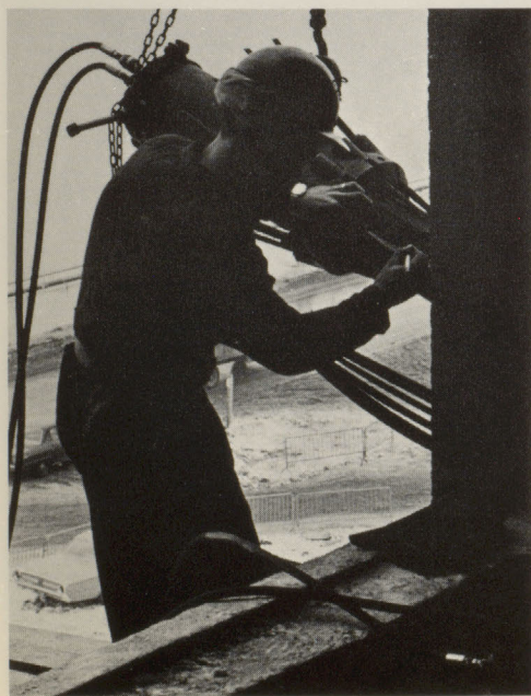
Post-tensioning of a concrete box. On soumet à la "post-tension" un élément d'habitation.
