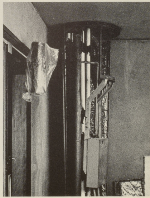
One fiberglass shaft provides mechanical and electrical services for a cluster of eight boxes. Un seul câble distributeur peut alimenter (chauffage, eau, et électricité) une grappe composée de huit cellules modulaires.
